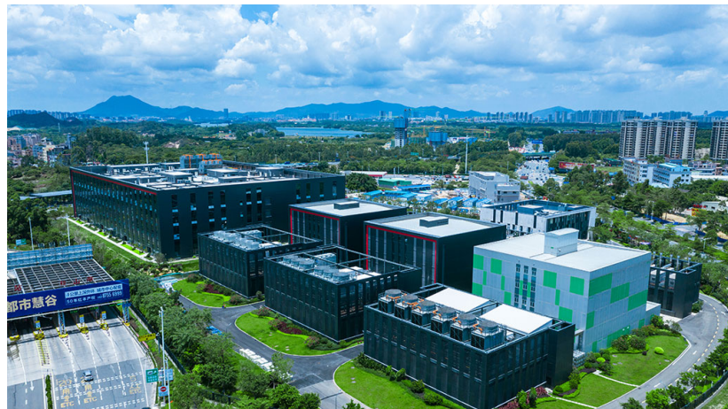
华为云数据中心
